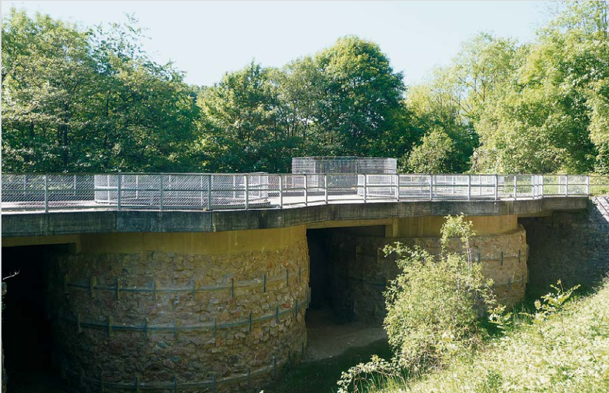
Kalkbrennöfen bei Walheim.
