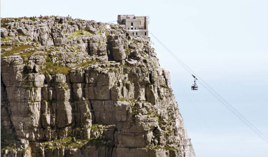
Upper Cable Station auf dem Tafelberg.
