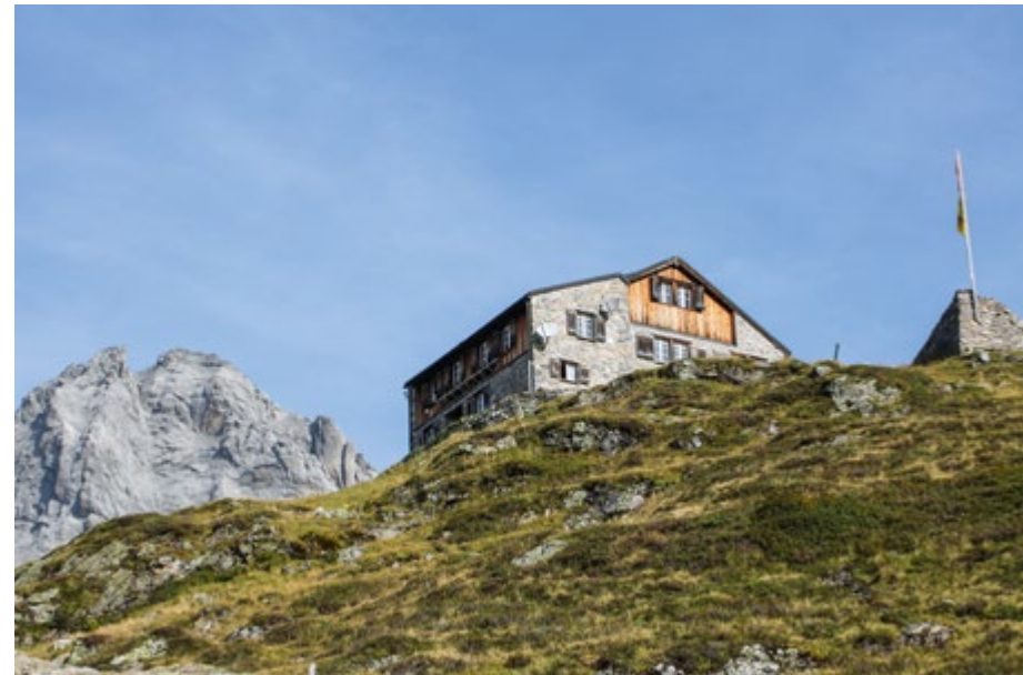
Schön geräumig: die Windgällenhütte.
