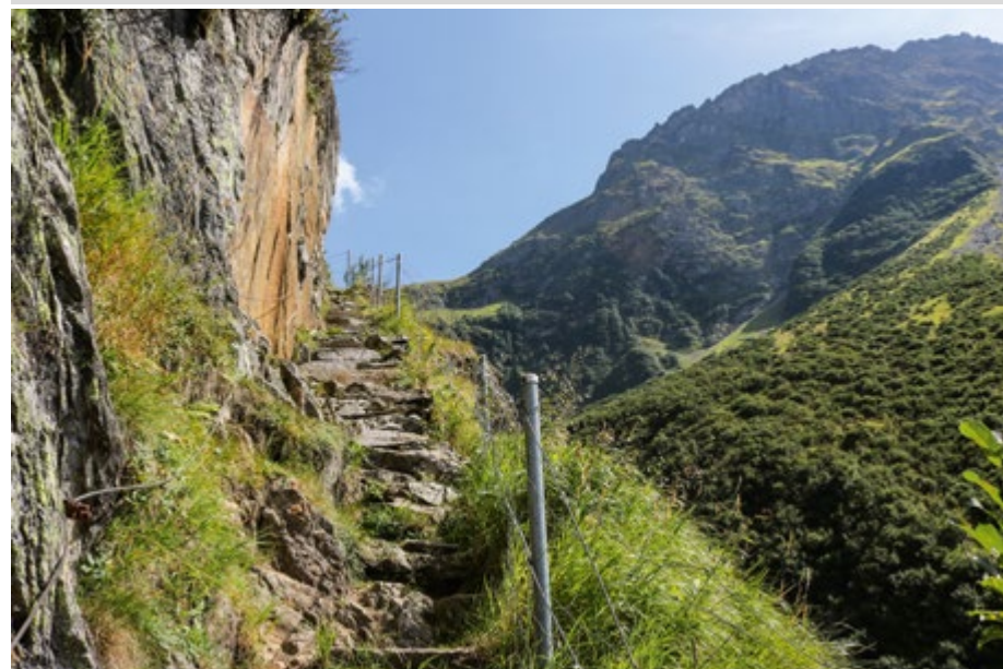
Die Felswegpassage unterhalb Hinterbalm.
